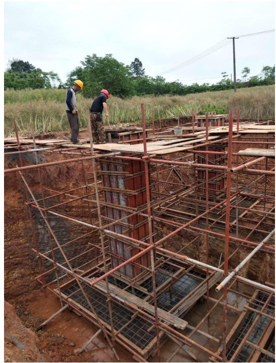
5#塔基基础支模
