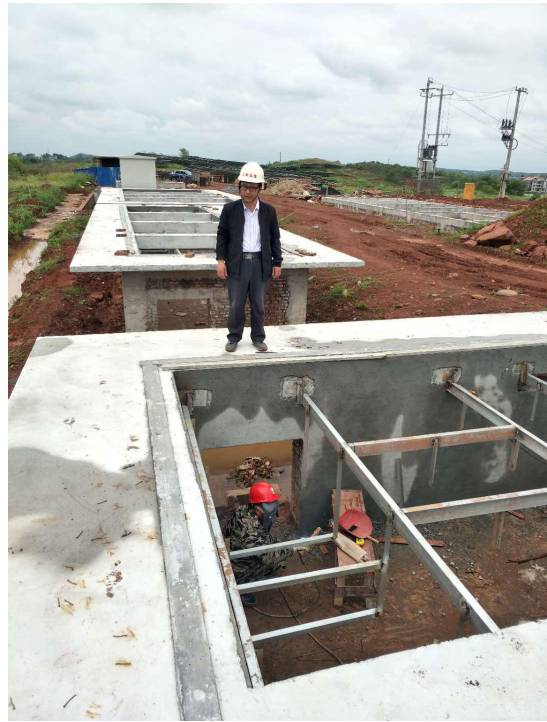
监理检查开关站二次舱电缆桥架焊接
