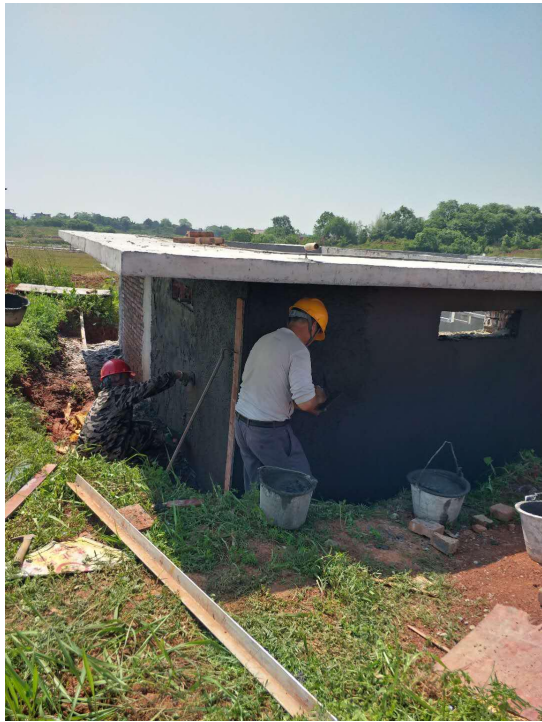
移交站基础墙面抹灰
