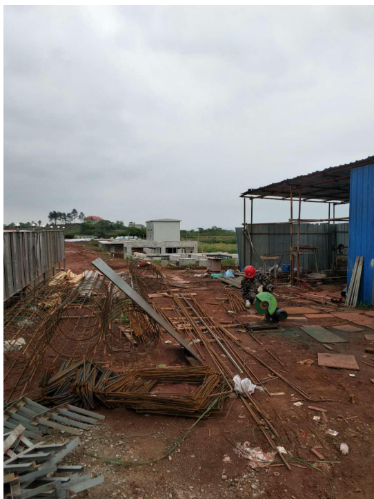
1#塔基基础焊接钢筋笼
