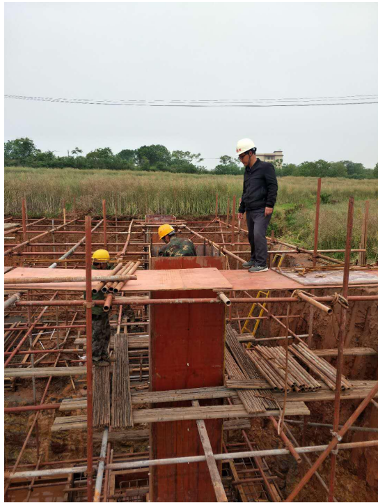
监理人员检查 5#塔基支模施工
