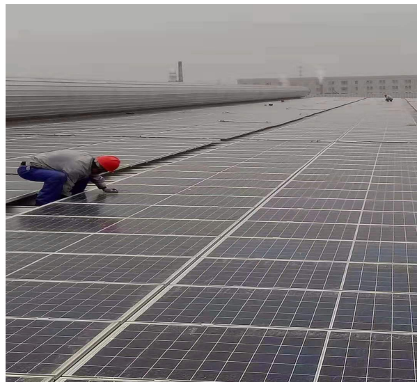
光伏组件安装
