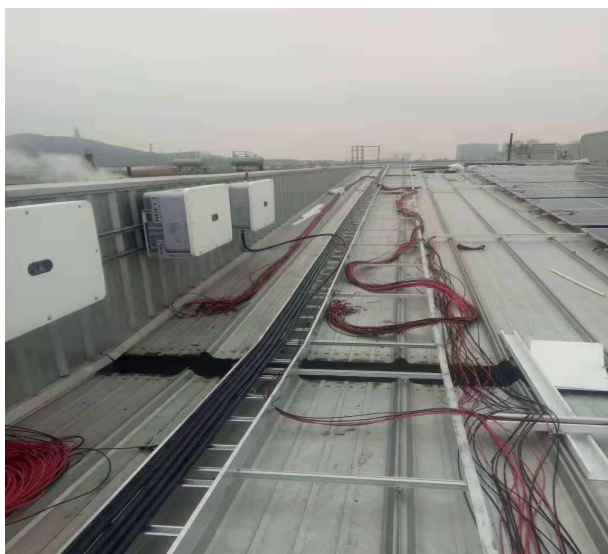
光伏电缆接线
