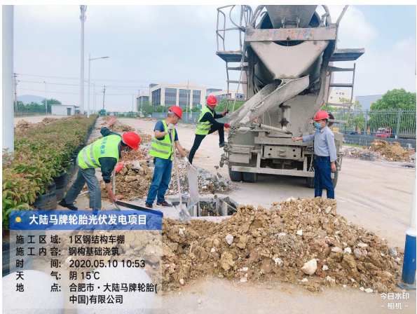
车棚基础浇筑
