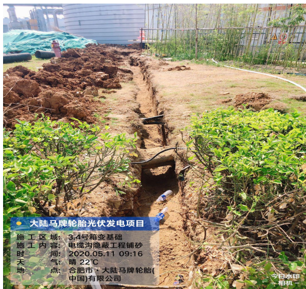
电缆沟隐蔽铺沙盖砖
