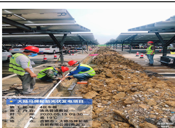
4区车棚清洗系统施工
