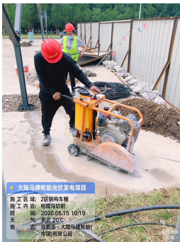
2区车棚电缆沟切割
