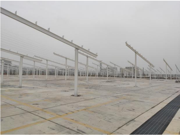
钢结构立柱及斜梁安装
