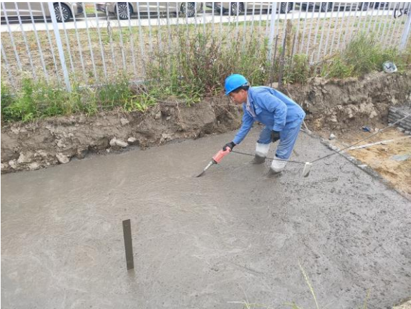
设备基础混凝土浇筑振捣
