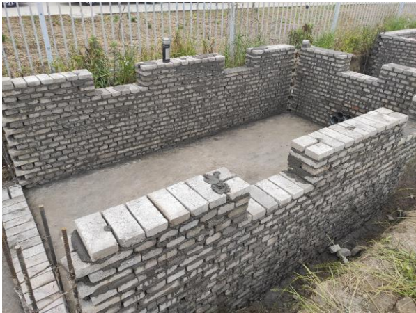
设备基础矮墙砌筑
