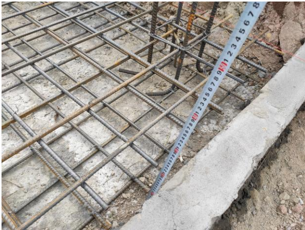
设备基础钢筋笼
