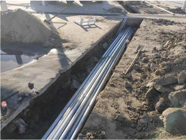
电缆沟穿线管敷设
