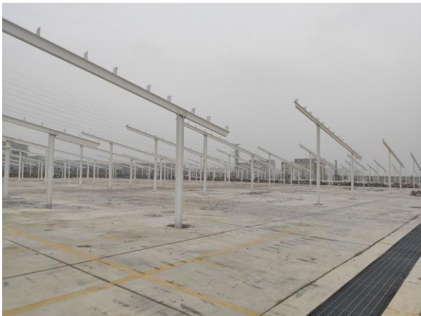
钢结构立柱斜梁安装半成品
