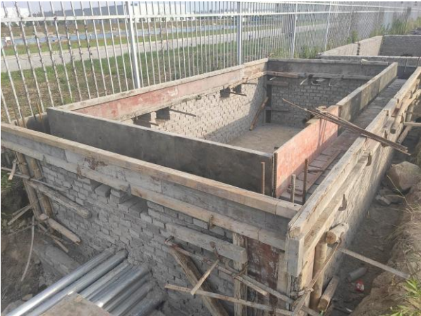
设备基础圈梁支模
