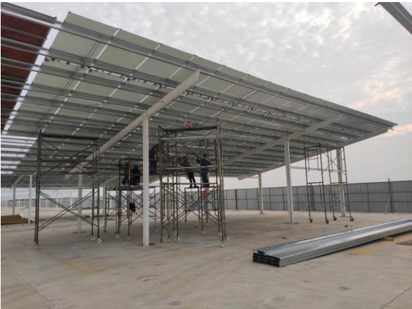
组件安装螺栓固定
