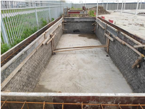
设备基础圈梁钢筋绑扎
