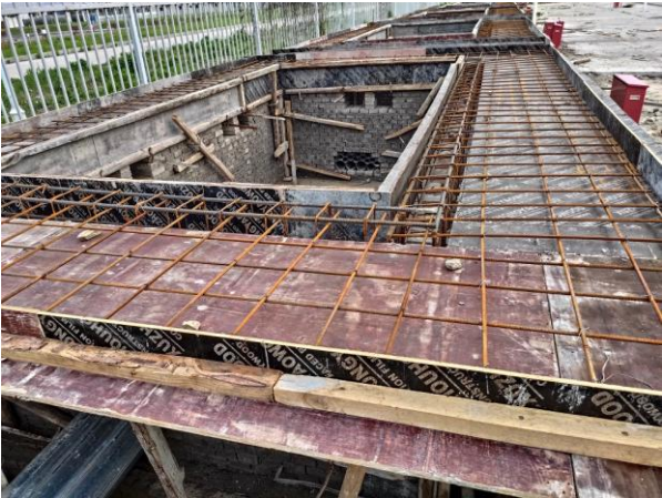
设备基础平台钢筋绑扎
