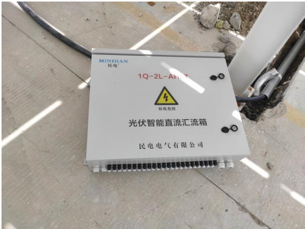
直流汇流箱准备安装
