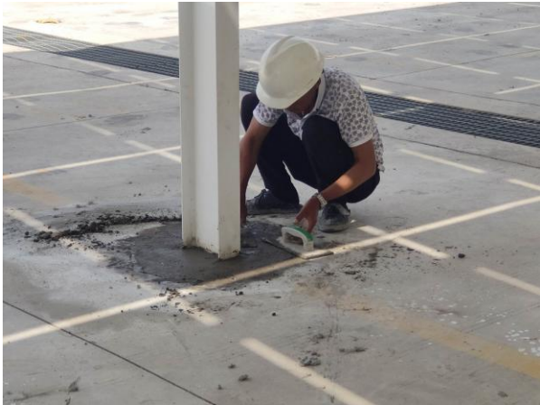
钢结构基础二次浇筑抹平
