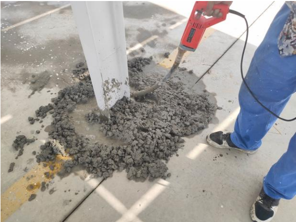
钢结构基础二次浇筑振捣
