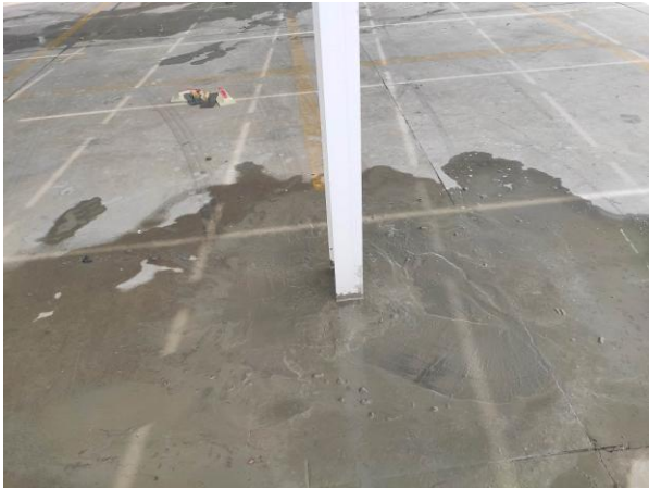
钢结构基础二次浇筑抹平
