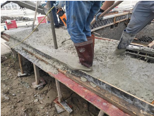
设备基础平台砼浇筑振捣
