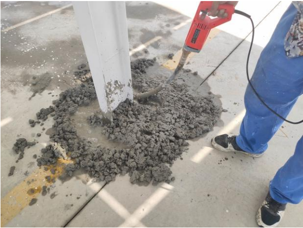
钢结构基础二次浇筑振捣
