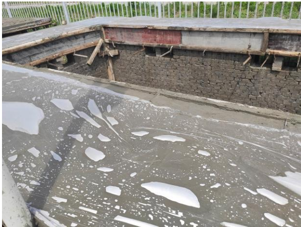
设备基础平台砼浇筑成品保护
