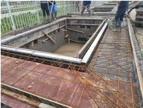
设备基础平台砼浇筑
