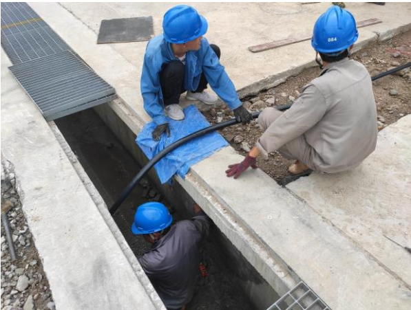
电缆沟进行电缆敷设穿管
