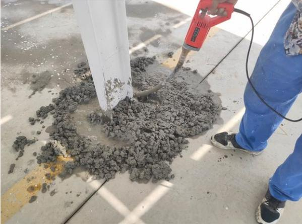
钢结构基础二次浇筑振捣
