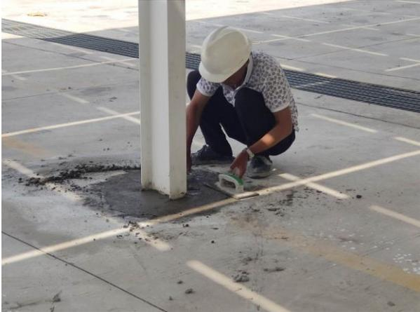
钢结构基础二次浇筑抹平
