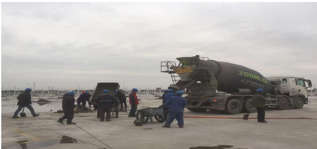
4、桩基开挖打桩施工
