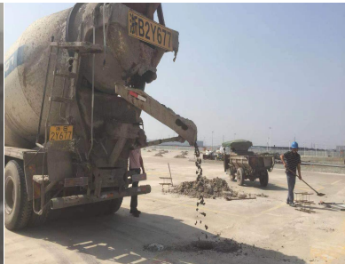
三区桩基砼浇筑
