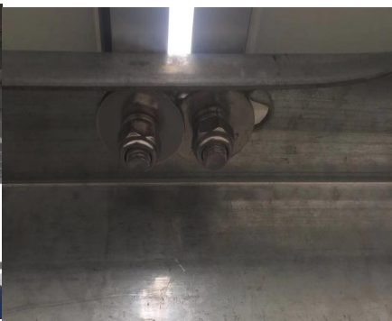
组件螺栓紧固
