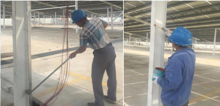
钢结构除锈补漆
