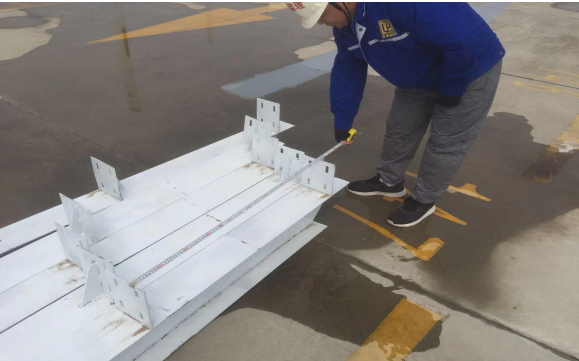
钢结构材料检查
