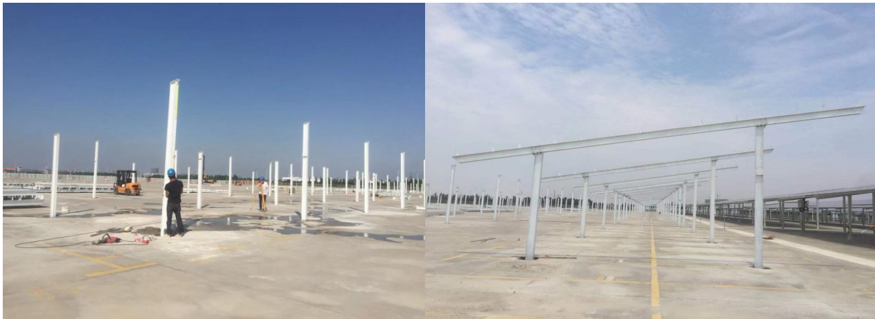
三区桩基础浇筑
