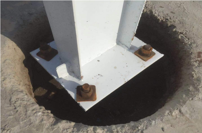
钢结构地脚螺栓安装检查
