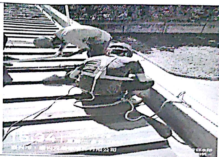
兄弟标准件施工点新屋面安全护网安装完成
