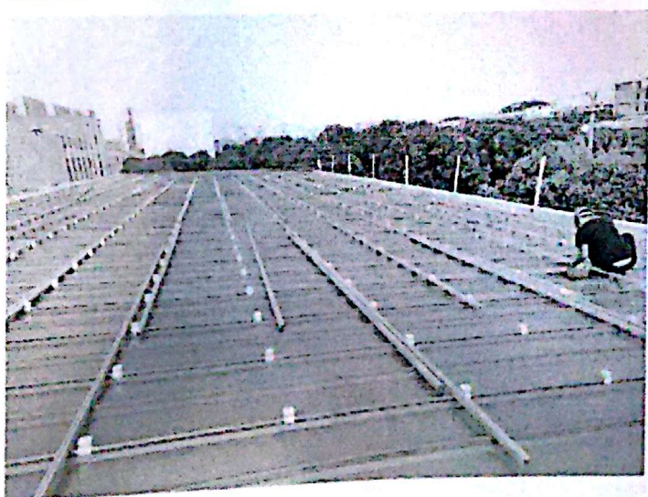
兄弟标准件施工点 5#屋面安装导轨
