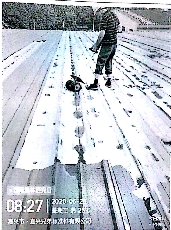
兄弟标准件施工点 3#屋面除锈刷漆
