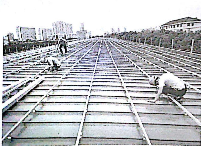
兄弟标准件施工点 5#屋面安装导轨
