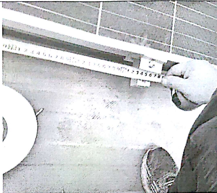
支架间距测量符合图纸要求 950mm
