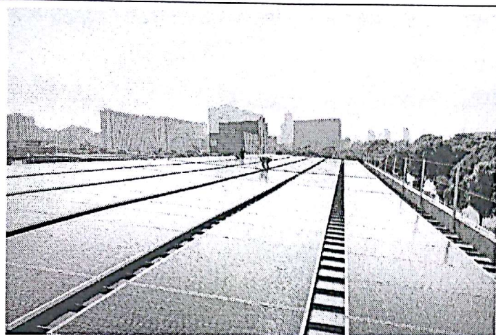
兄弟 1#屋面组件安装完成
