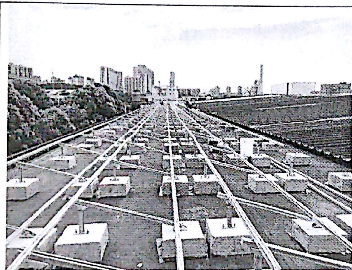
兄弟 3#屋面水泥顶支架安装
