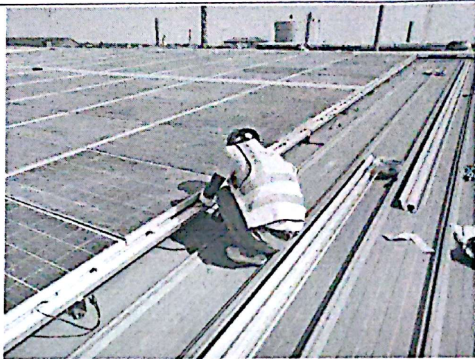
壁丽雅屋面导轨、组件安装
