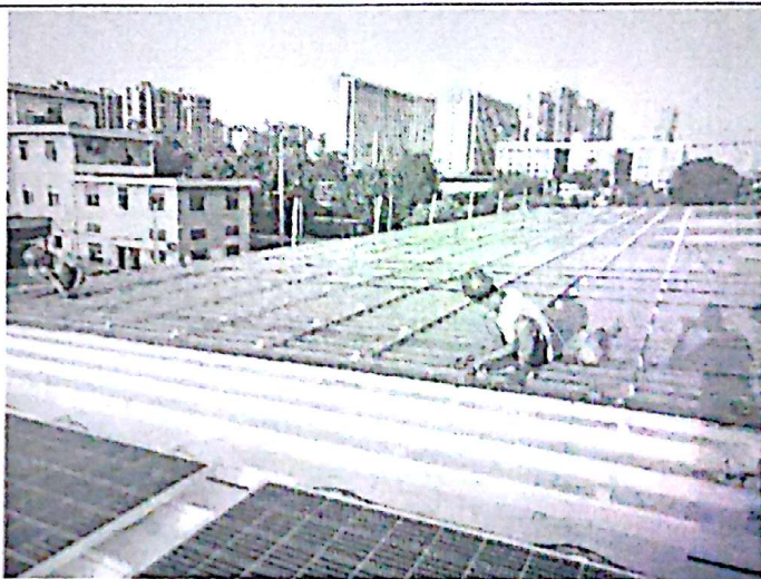
兄弟 4#屋面安装夹具、导轨
