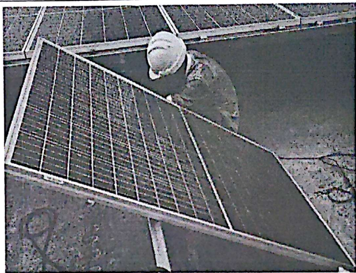
巨润屋面组件安装
