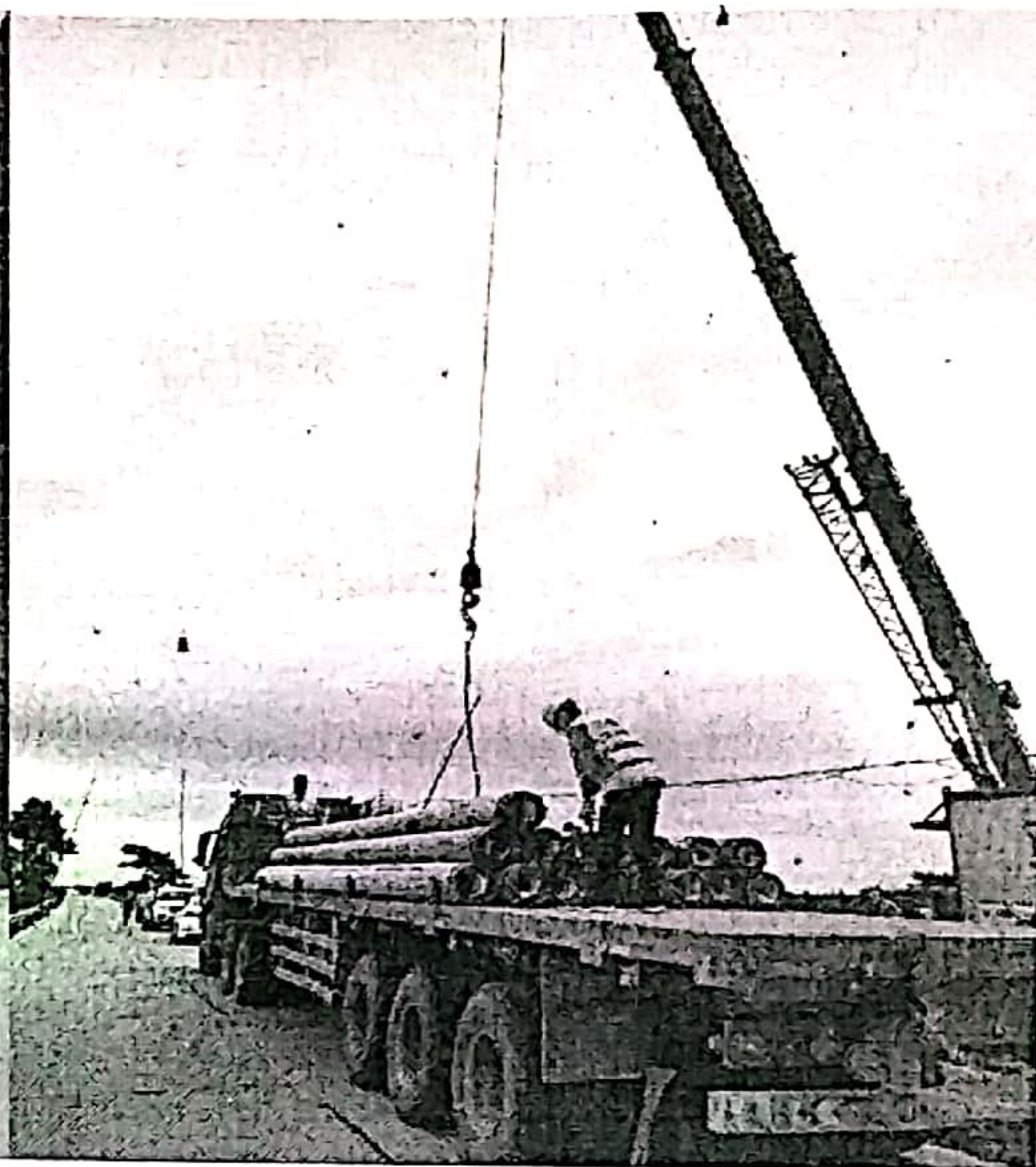
2020.06.09 管桩进场吊卸
