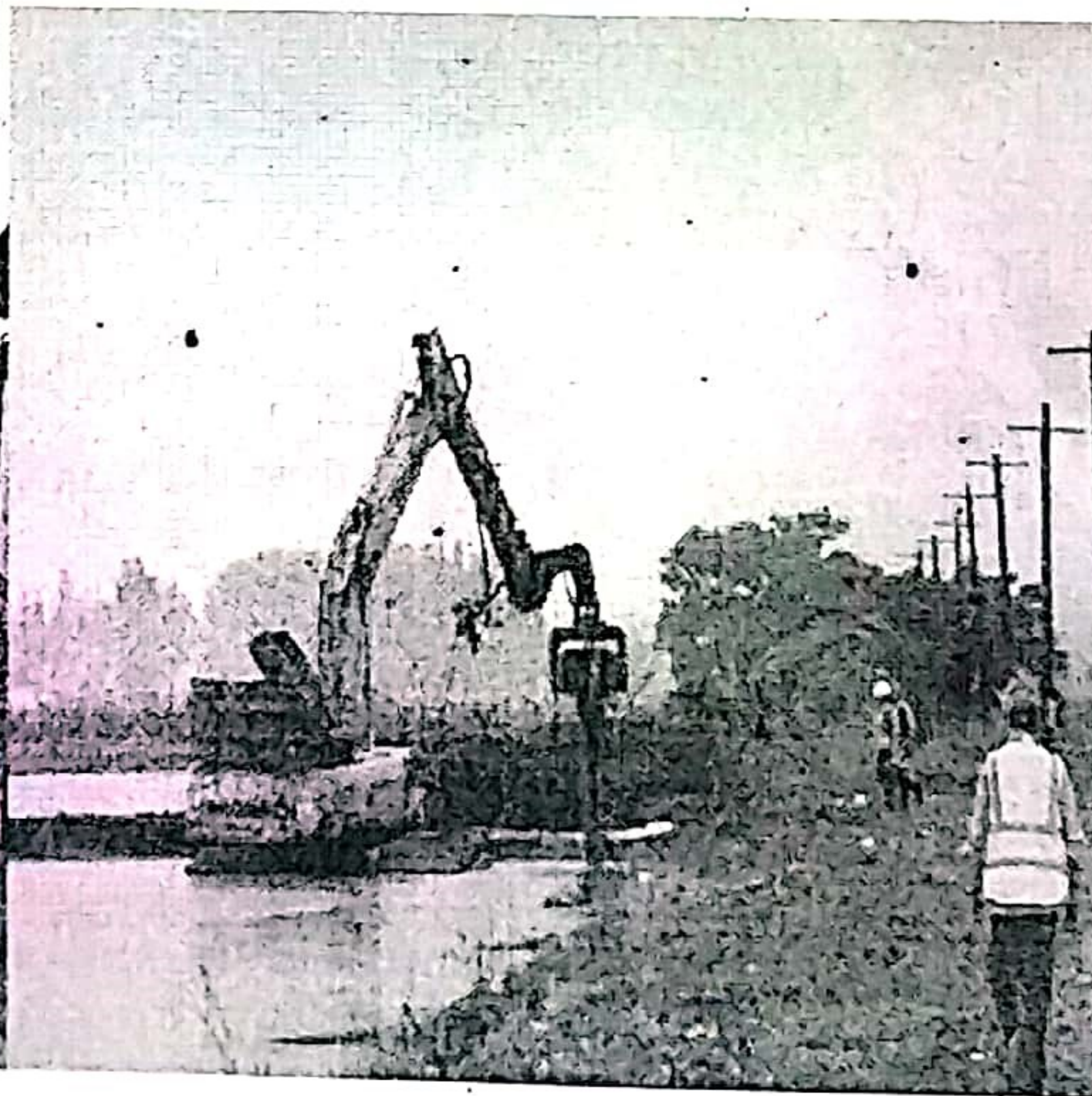
2020.06.11 试打第一根管桩
