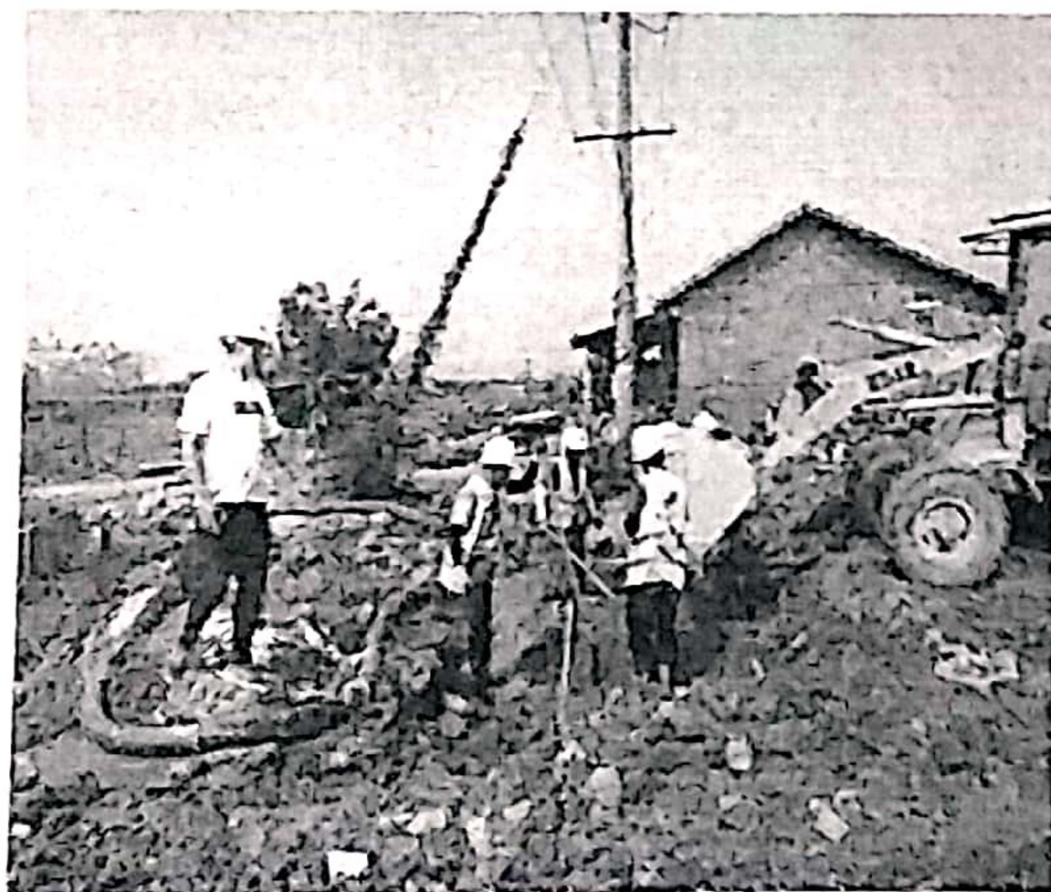
电缆井垫层浇筑
