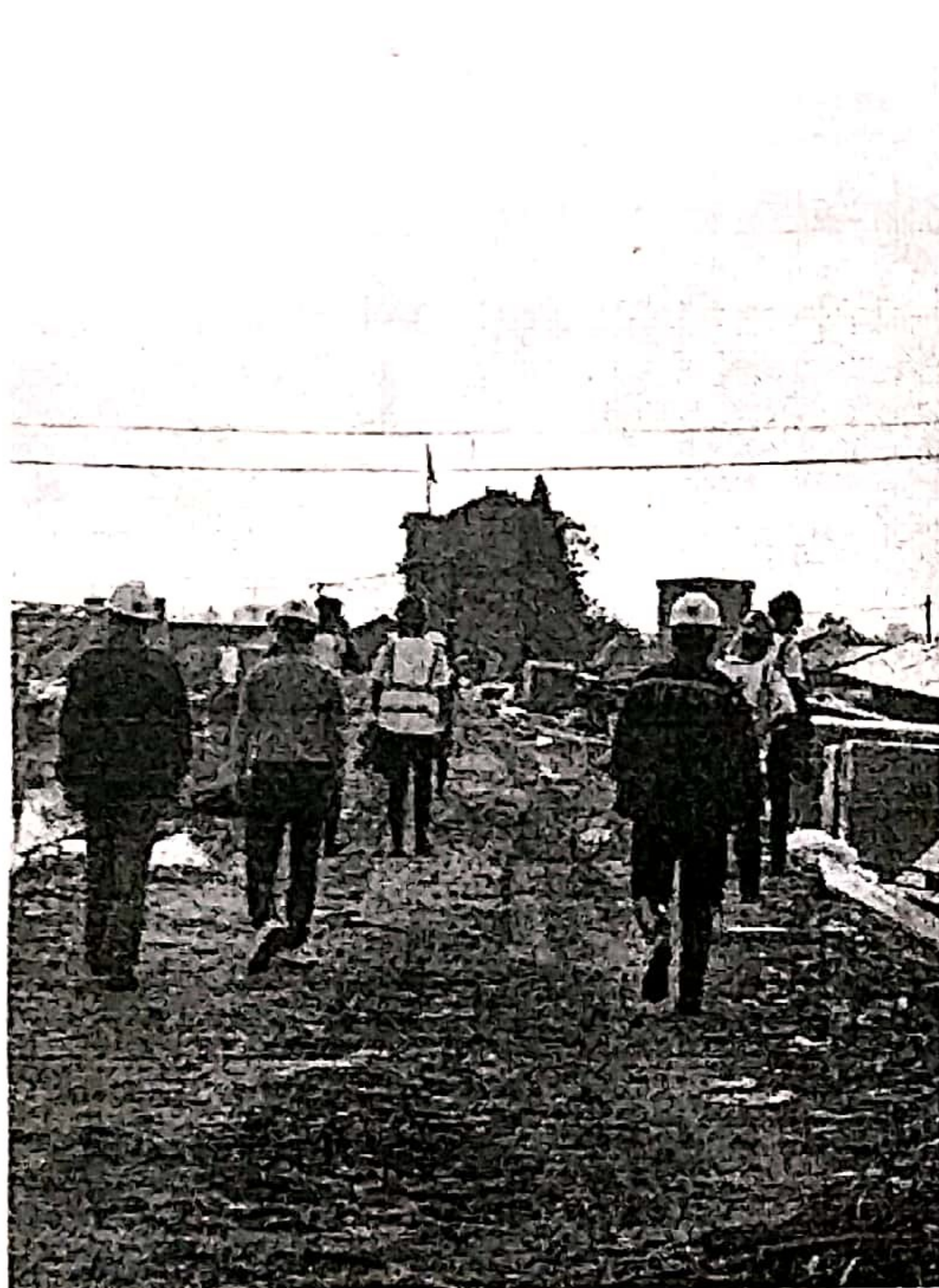
四方组织对施工现场进行安全大检查
