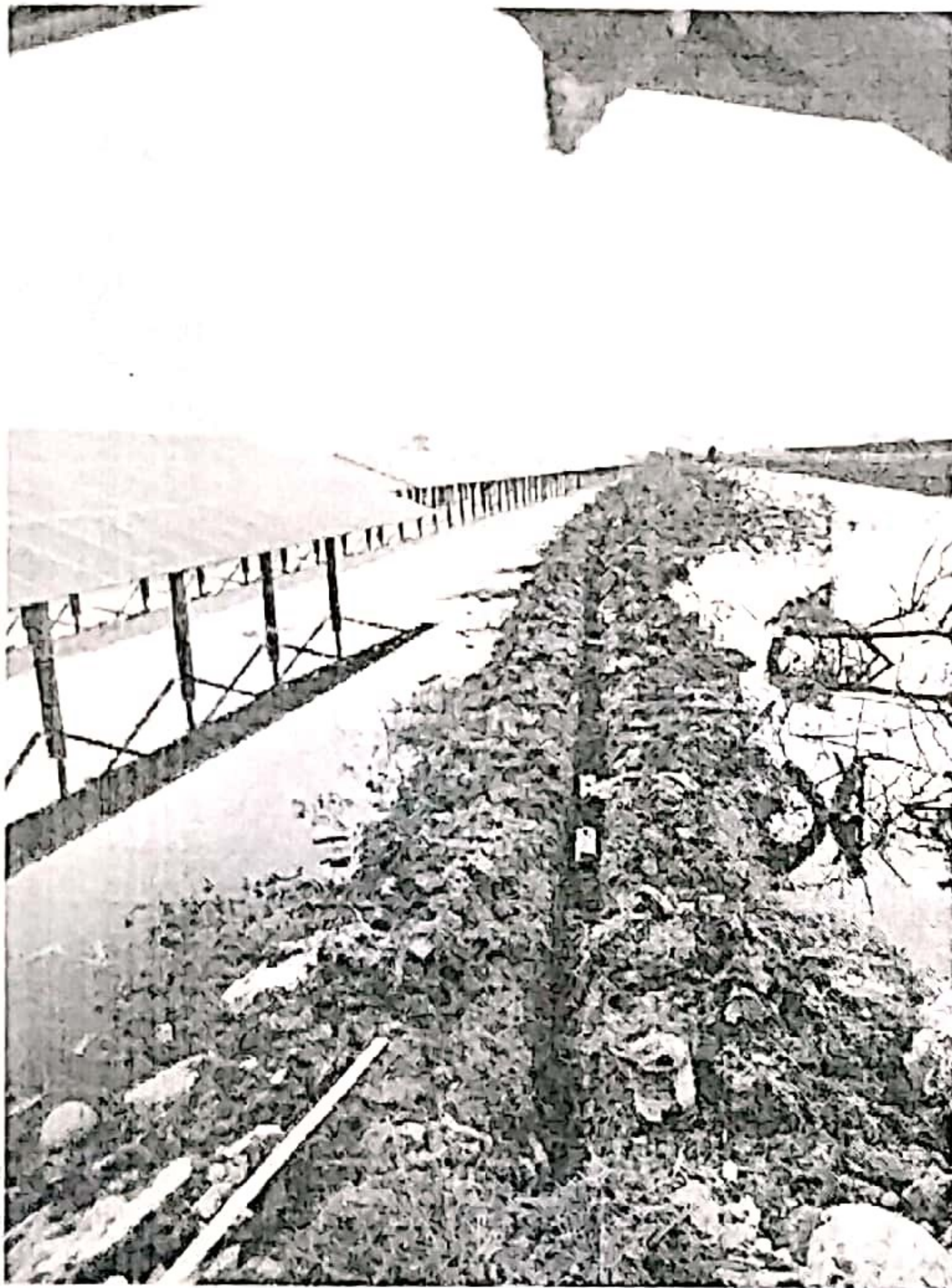
接地环网施工
