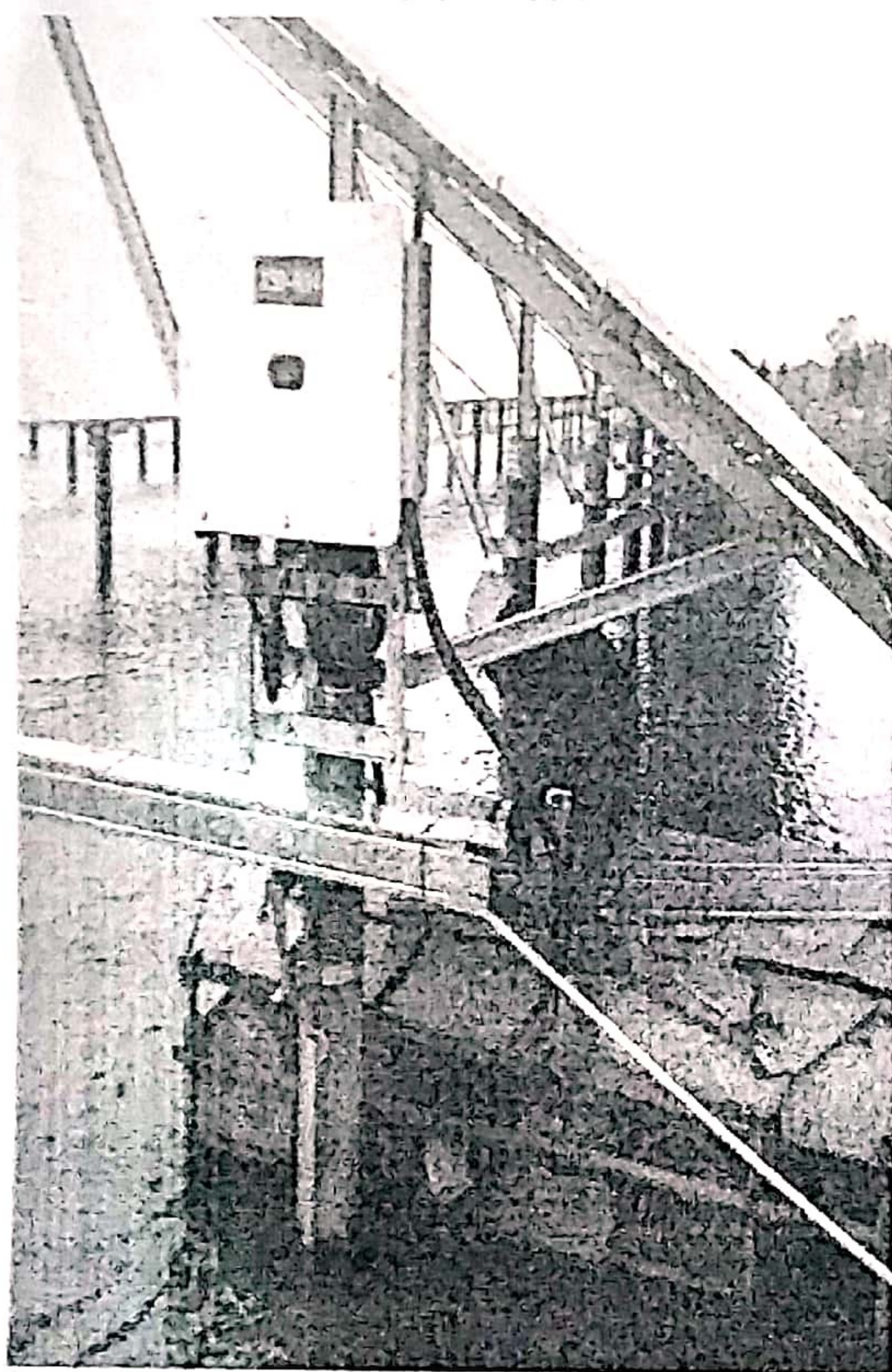
桥架盖板安装
