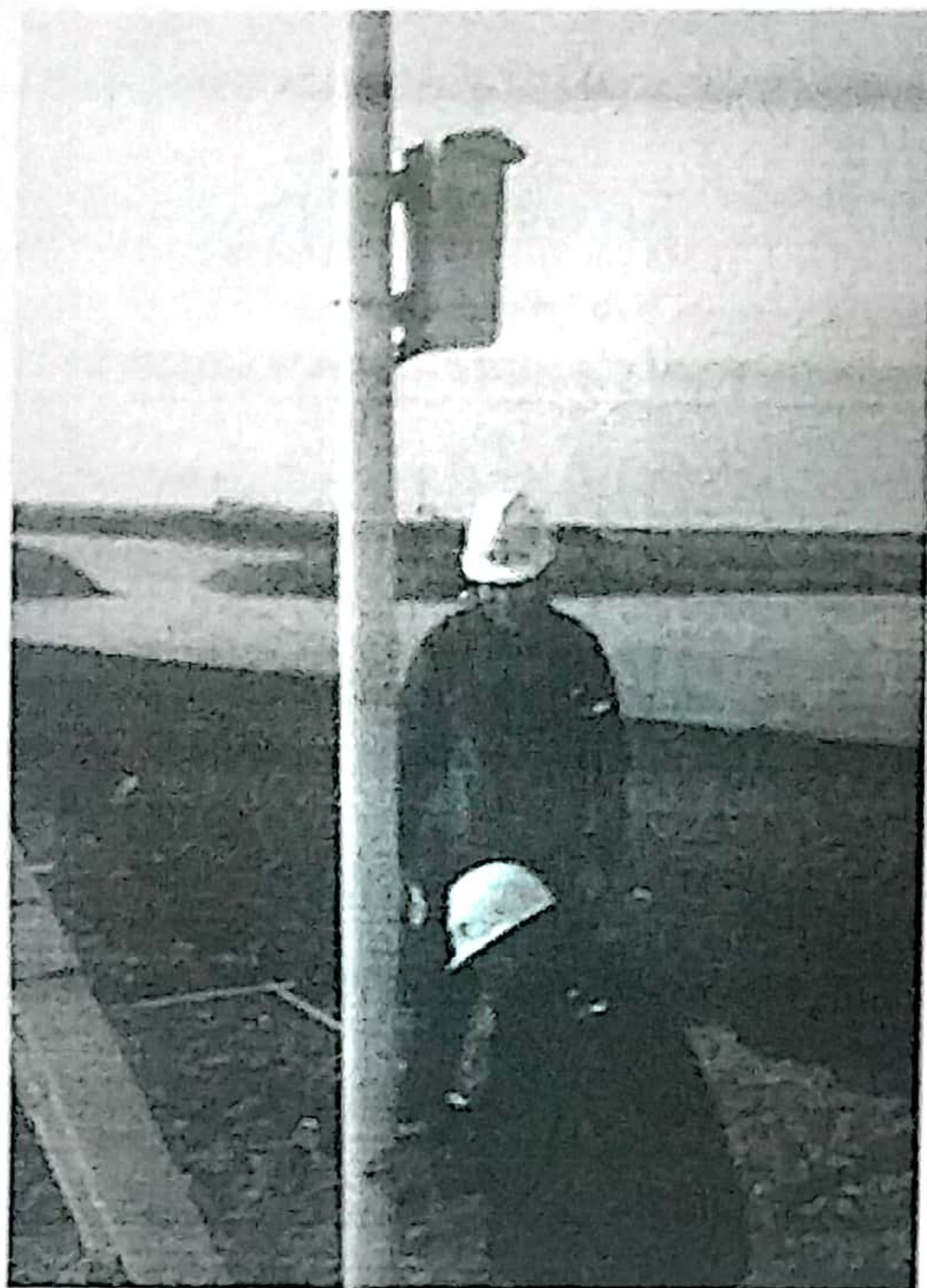
场区监控检查验收
