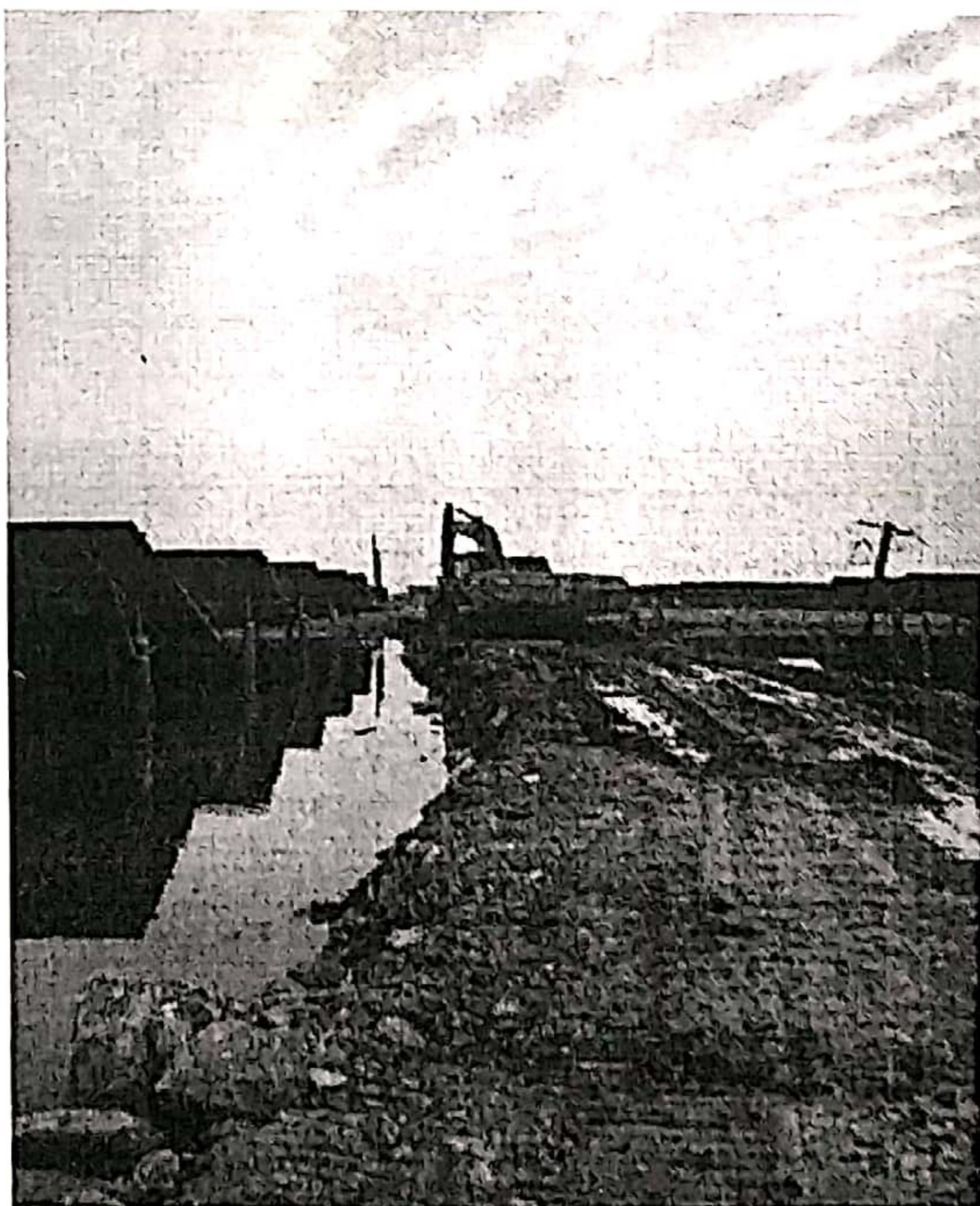
道路面层铺筑
