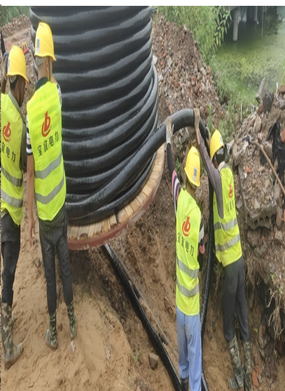
现场 1 号、2 号集电线路电缆敷设
