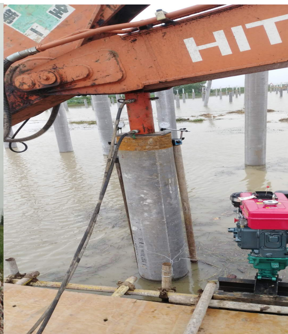
现场 A3 区单桩竖向抗压静载试验
