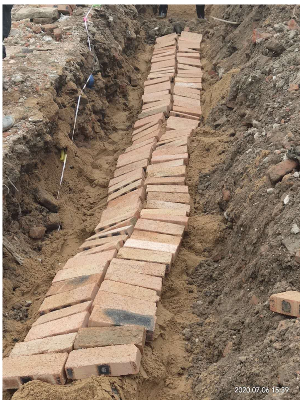
电缆敷设、铺沙、盖砖完成
