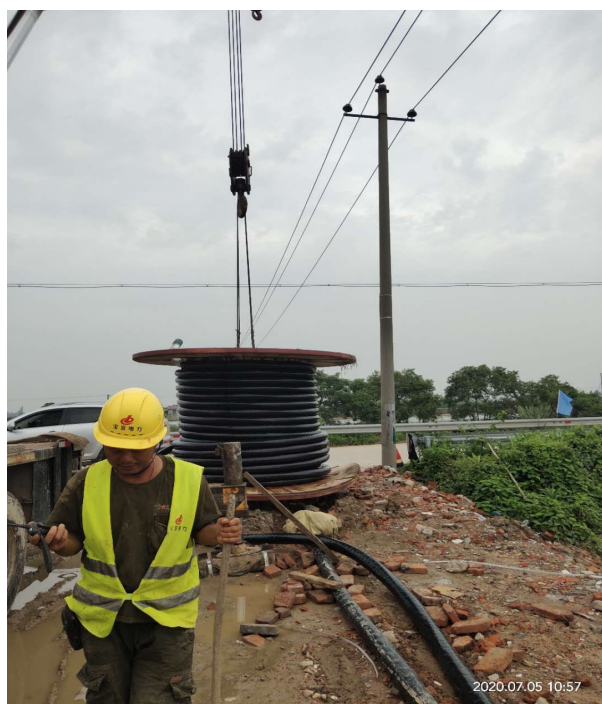
现场 5 号集电线路敷设
