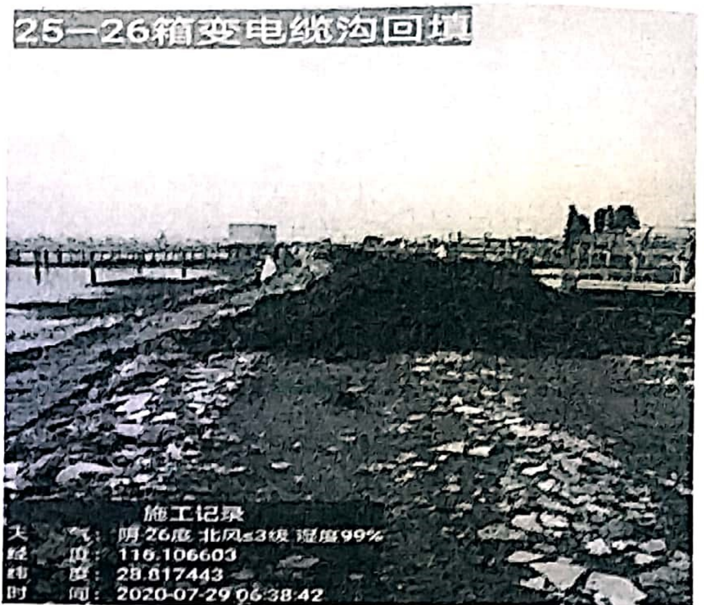
25#-26#箱变电电缆沟回填
