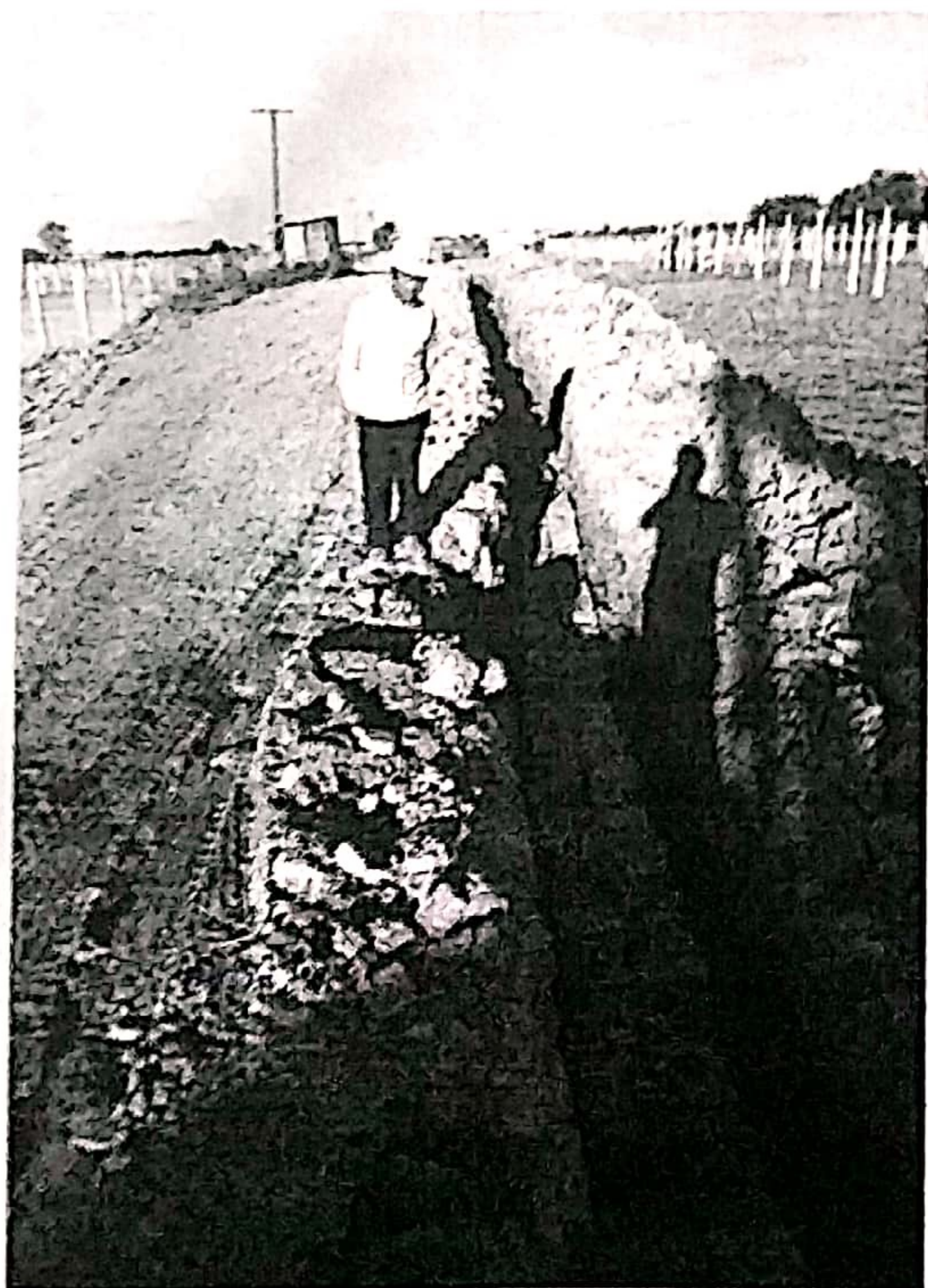
检查现场 1#-4#箱变电电缆沟铺沙盖砖
