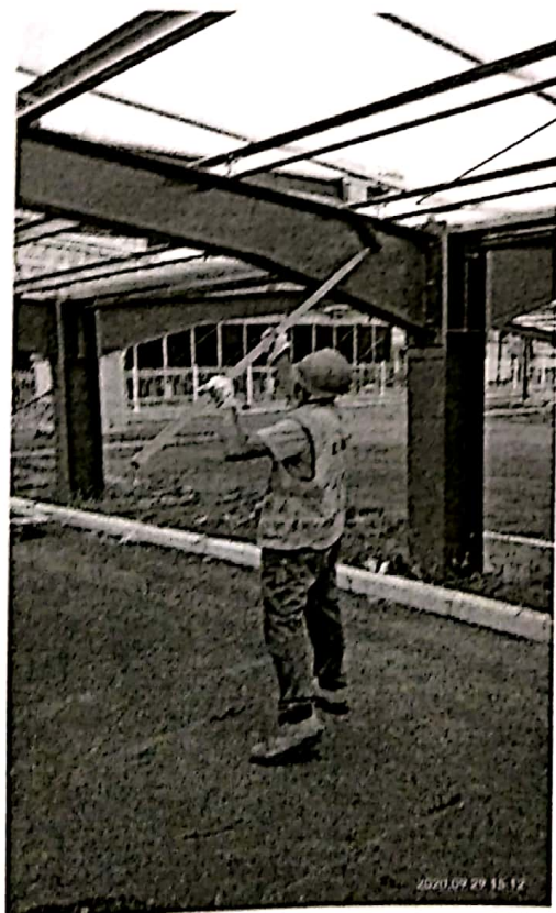
车棚钢结构斜梁二次刷漆
