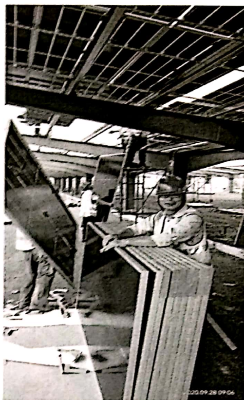
车棚光伏组件安装
