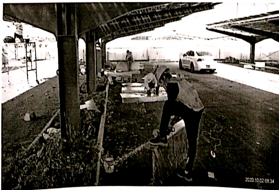
停车场施工区域电气人员加工、裁剪、下料组串式逆变器、汇流箱进行保护装置
