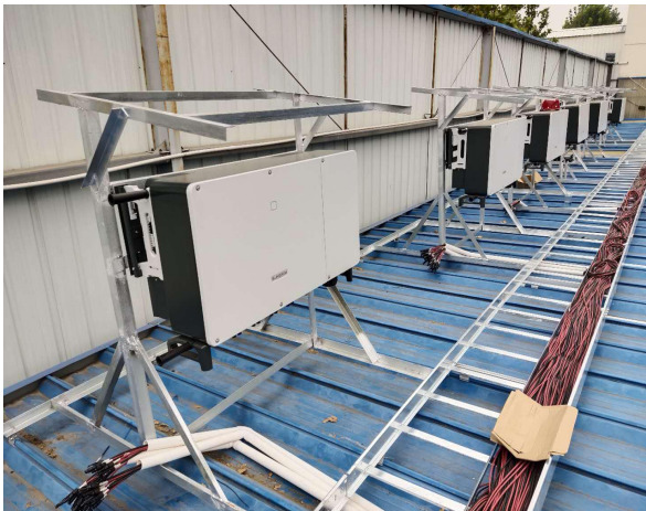
光伏并网逆变器安装固定
