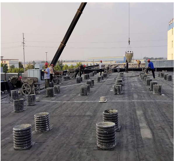
配重块砼浇筑制作
