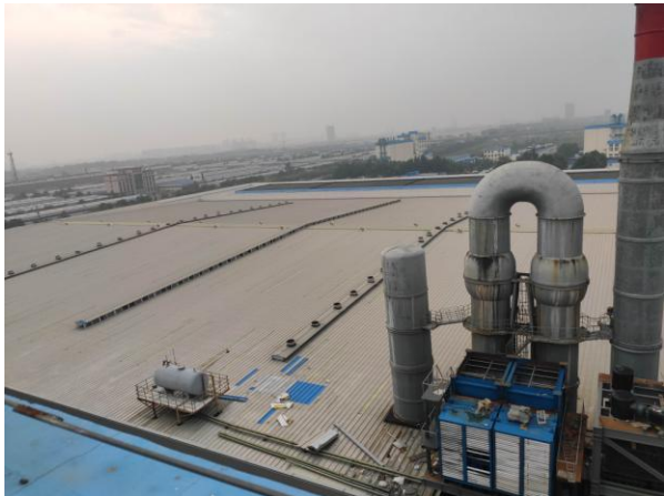
沙河厂区屋顶考察
