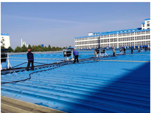
交流电缆敷设
