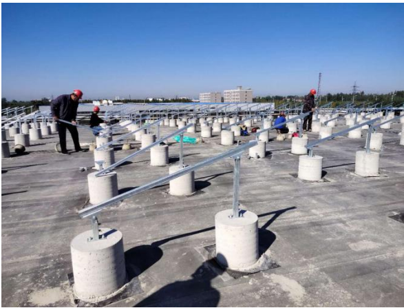
南和厂区光伏支架安装
