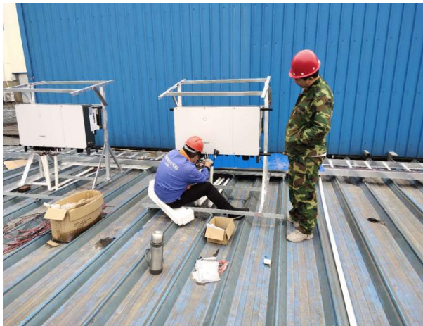
光伏并网逆变器接线
