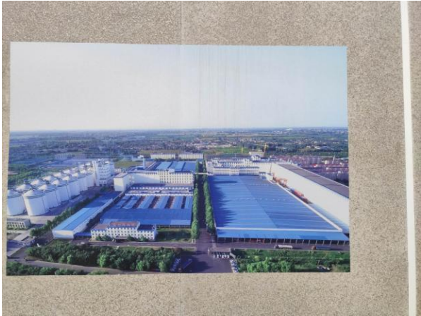
南和厂区俯瞰图
