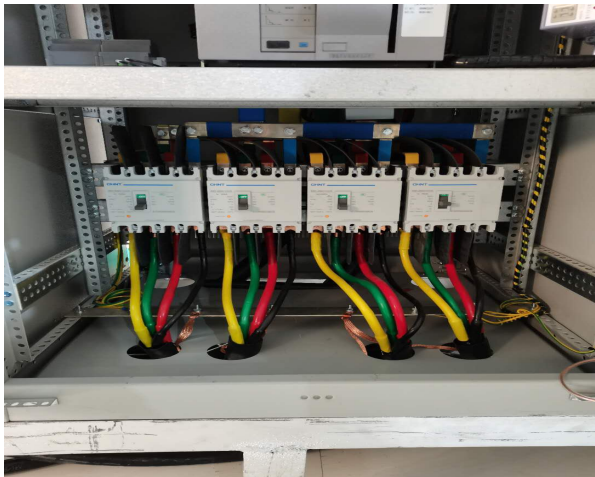
光伏并网柜接线安装
