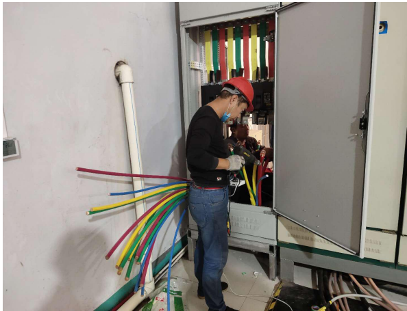
铜鼻子制作接线
