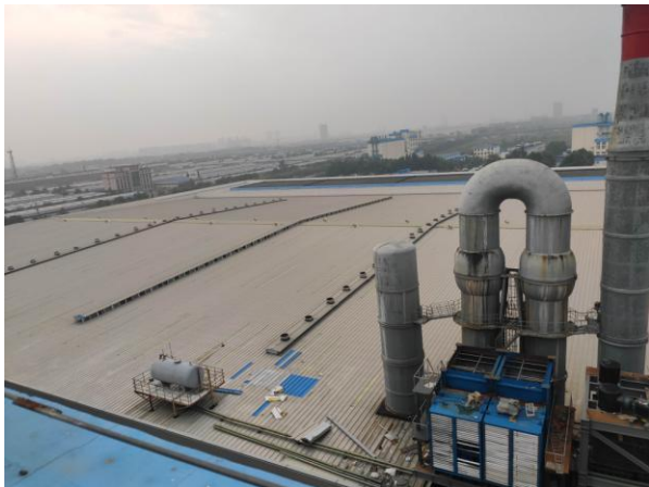
沙河厂区屋顶考察
