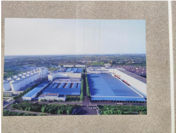
南和厂区俯瞰图
