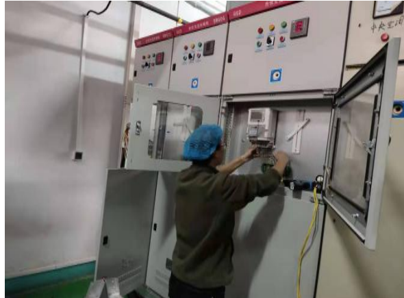
光伏交流并网柜电表安装
