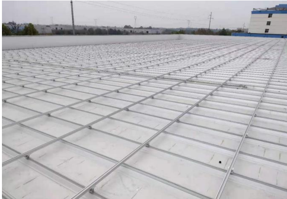
沙河厂区导轨安装
