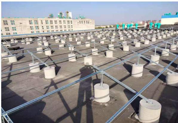
南和厂区光伏支架安装
