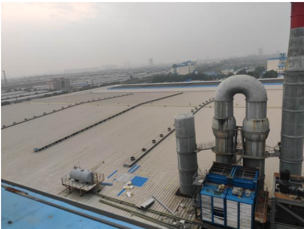
沙河厂区屋顶考察
