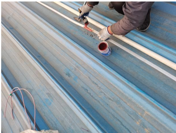
南和厂区接地防腐
