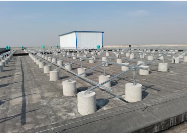
沙河厂区支架安装
