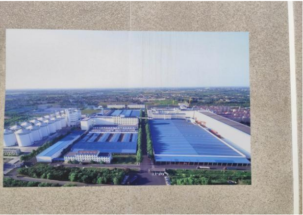
南和厂区俯瞰图
