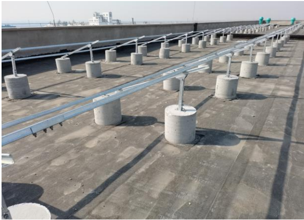
沙河厂区支架安装
