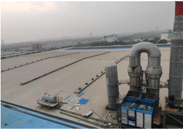
沙河厂区屋顶瞰图
