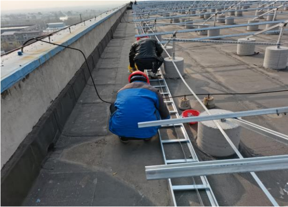
南和厂区桥架安装1
