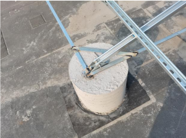
南和厂区接地材料焊接1
