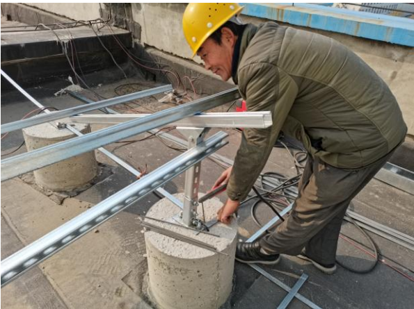
南和厂区接地材料焊接2
