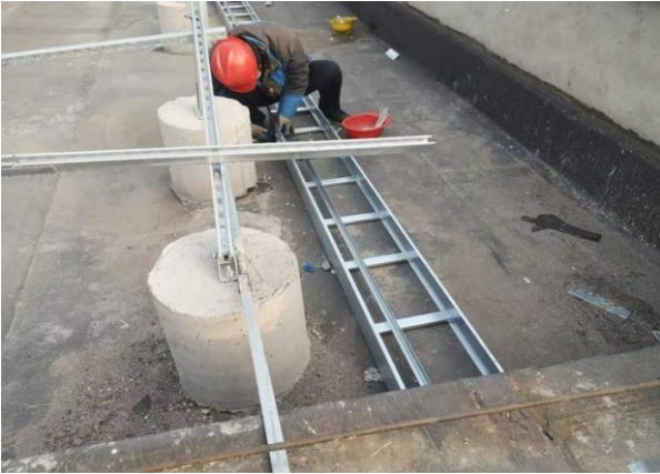
南和厂区桥架安装2
