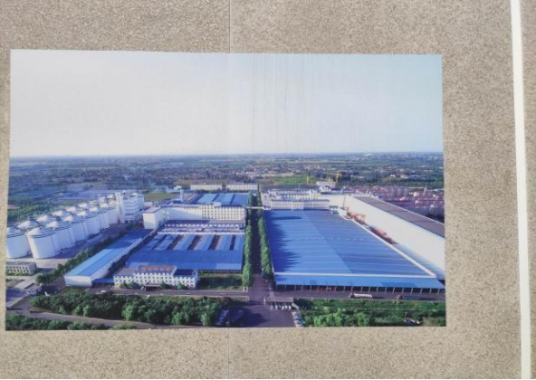
南和厂区俯瞰图
