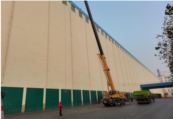
南和厂区组件吊运
