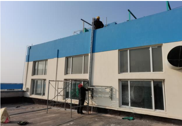
南和厂区桥架安装1
