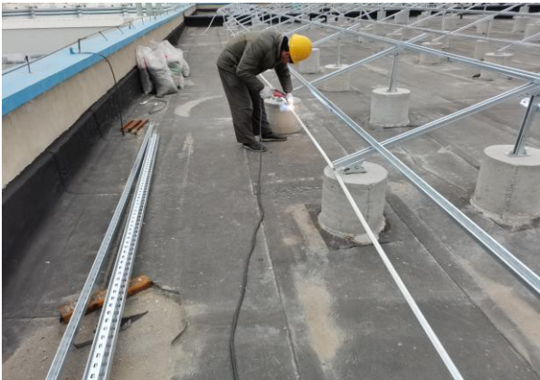
南和厂区接地材料焊接2
