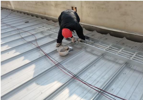
南和厂区桥架安装2
