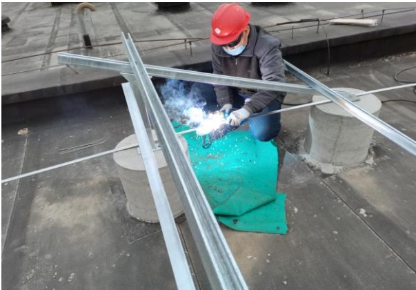
南和厂区接地材料焊接1
