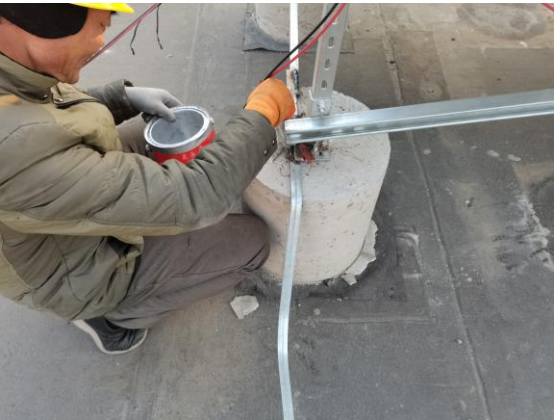
南和厂区接地材料防腐刷漆
