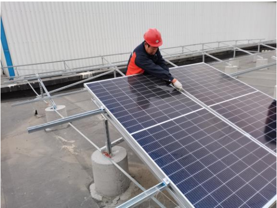
南和厂区组件安装1
