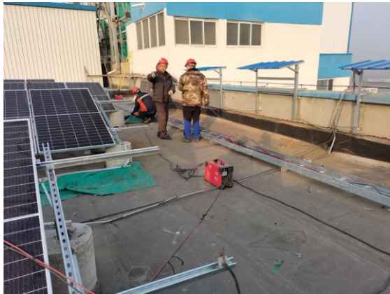
南和厂区光伏线缆敷设
