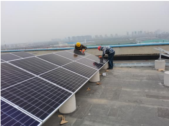
南和厂区组件安装2
