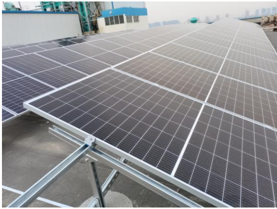
南和厂区光伏组件安装
