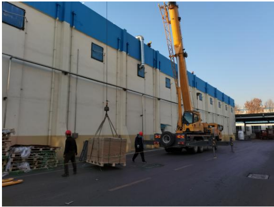
南和厂区组件吊运2
