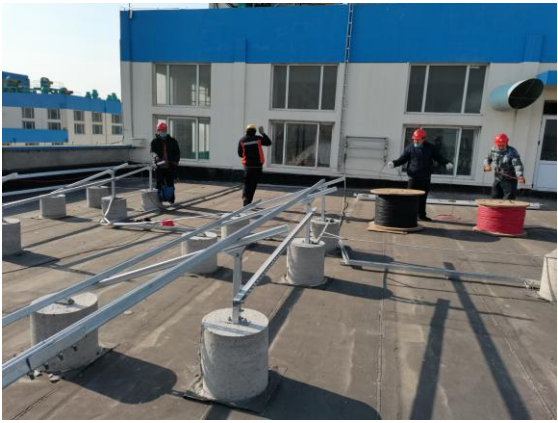
南和厂区光伏线缆敷设
