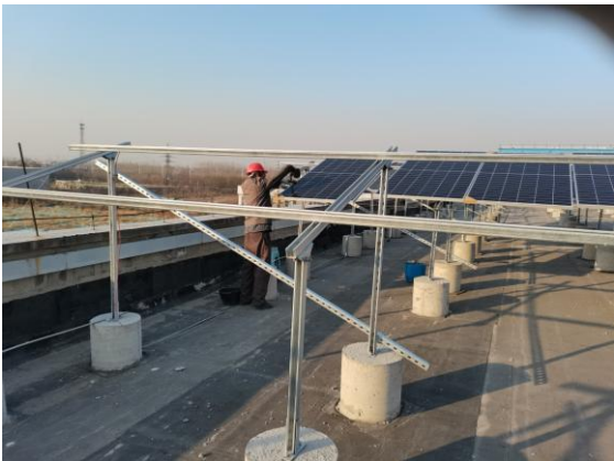
南和厂区组件安装2
