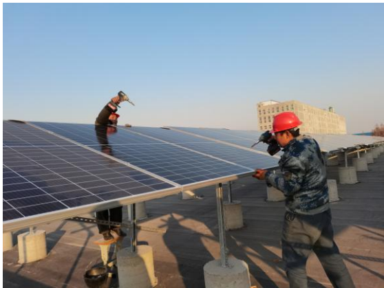
南和厂区组件安装1
