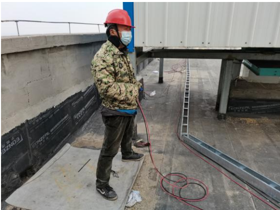
南和厂区光伏线缆敷设
