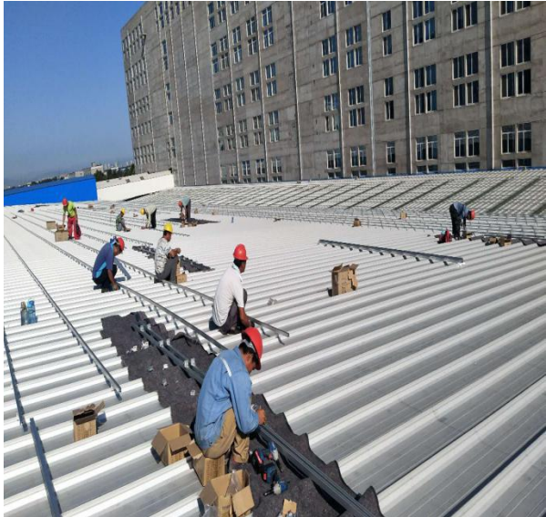
南和厂区导轨安装
