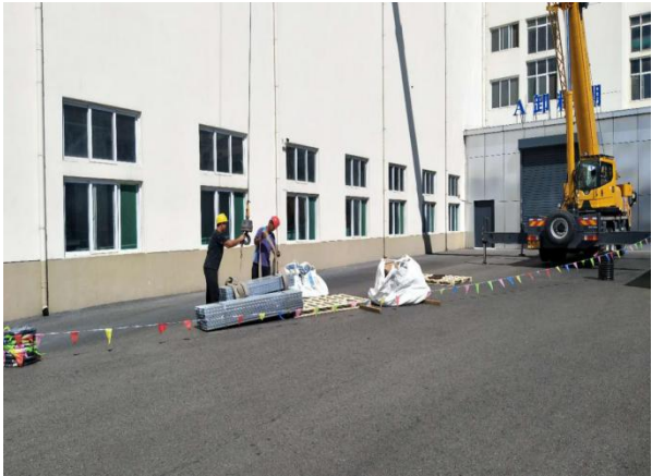
南和厂区导轨材料吊运
