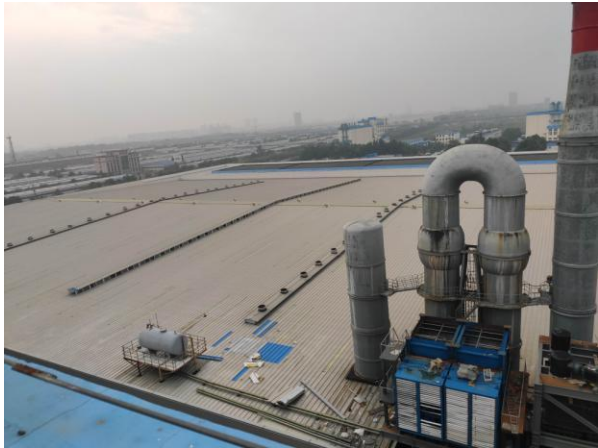
沙河厂区屋顶考察
