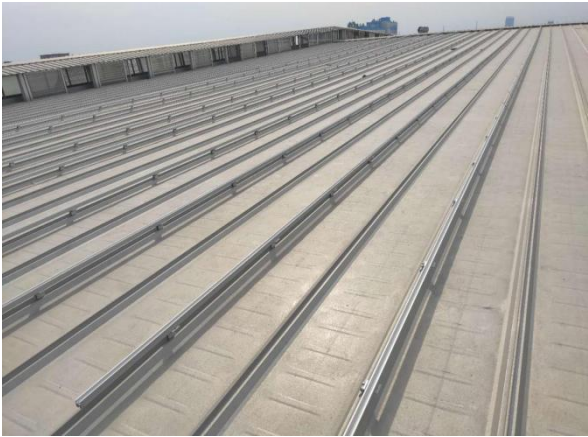
沙河厂区导轨安装
