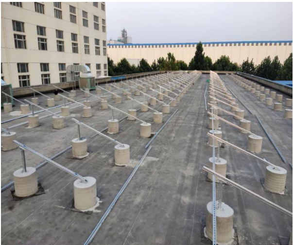
南和厂区光伏支架安装
