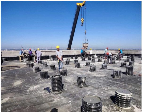
配重块砼浇筑制作
