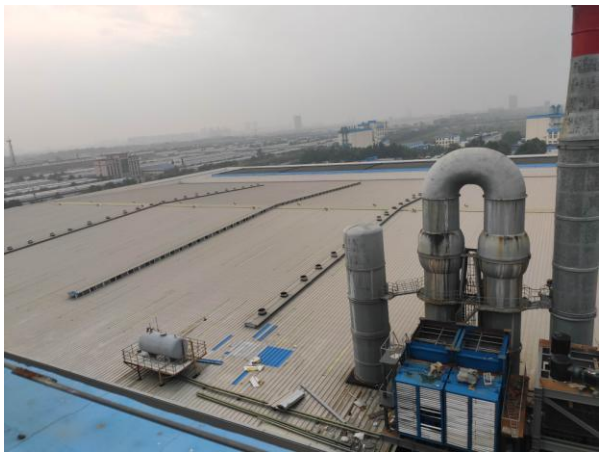
沙河厂区屋顶考察
