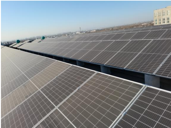
南和厂区锅炉房屋顶组件安装完成
