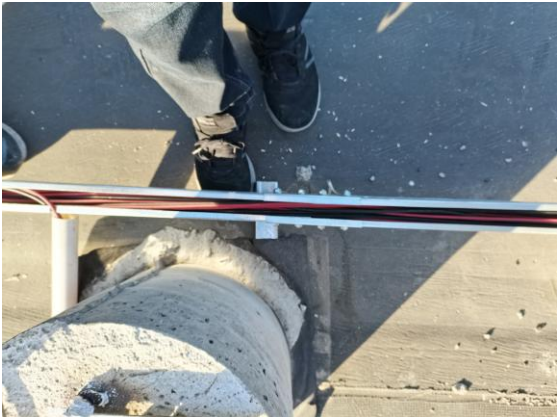
南和厂区桥架支架安装
