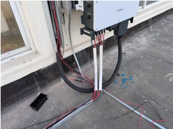
南和厂区逆变器光伏线缆接线
