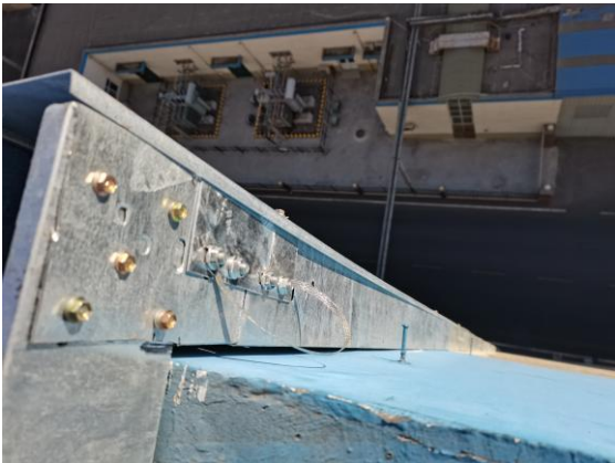
南和厂区制粉车间3桥架安装
