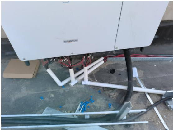
南和厂区制粉车间3逆变器安装接线
