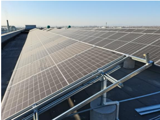
南和厂区制粉车间5屋顶组件安装完成
