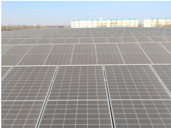
南和厂区制粉车间1屋顶组件安装完成
