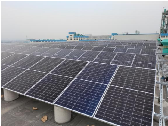
南和厂区制粉车间2屋顶组件安装完成
