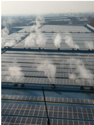
南和厂区挂面车间组件安装完成已并网。
