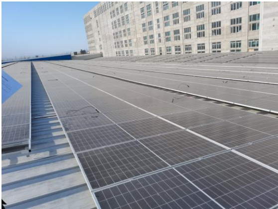
南和厂区成品库屋顶组件安装完成
