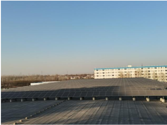
南和厂区锅炉房屋顶初具模样
