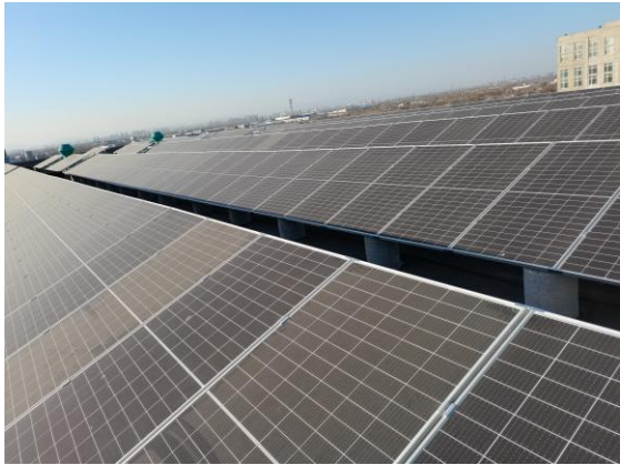
南和厂区制粉车间3屋顶组件安装完成
