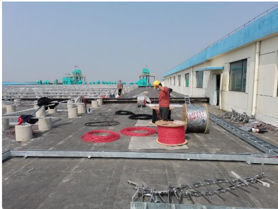
沙河厂区制粉车间屋桥架安装和线缆敷设
