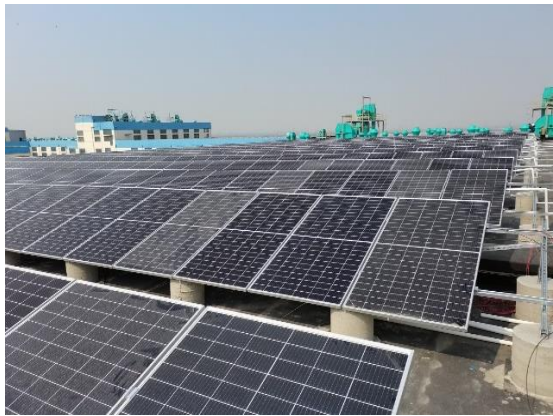
沙河厂区制粉车间组件安装初具规模
