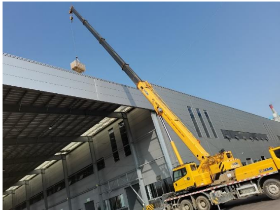
沙河厂区挂面车间屋组件吊运
