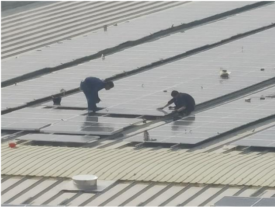
沙河厂区挂面车间屋顶组件安装完成
