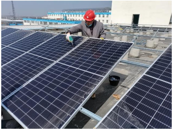
沙河厂区5000吨成品库屋顶组件安装
