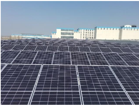
沙河厂区5000吨成品库组件安装完成
