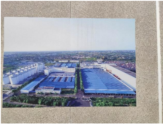
南和厂区俯瞰图
