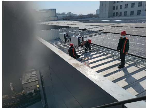
沙河厂区制水车间屋顶逆变器安装
