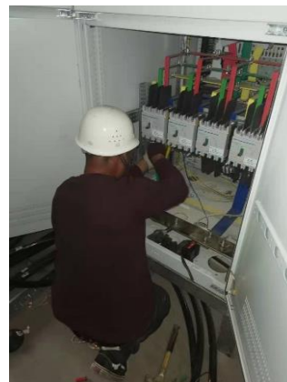
沙河厂区配电房线缆终端制作
