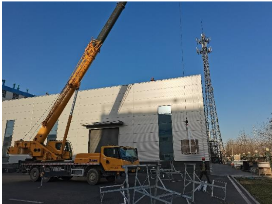
沙河厂区制水车间屋顶逆变器支架吊运
