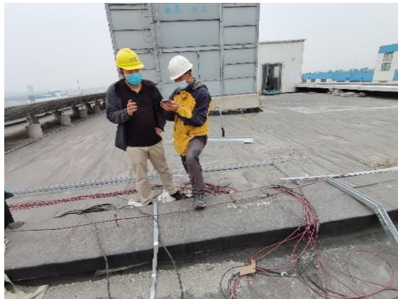
建设单位与施工单位管理人员进行交流
