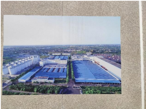
南和厂区俯瞰图
