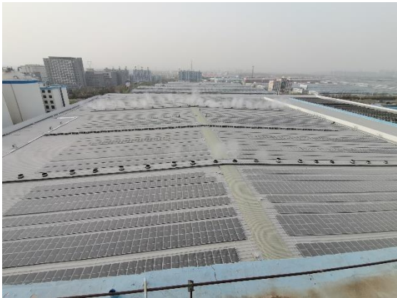
沙河厂区“挂面车间”屋顶成品雏形
